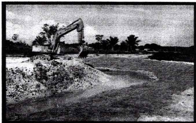
Obra de adequação para macro drenagem na sede de Rorainópolis. Fonte: Adan Santos
