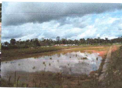
Lagoa de estabilização inoperante
