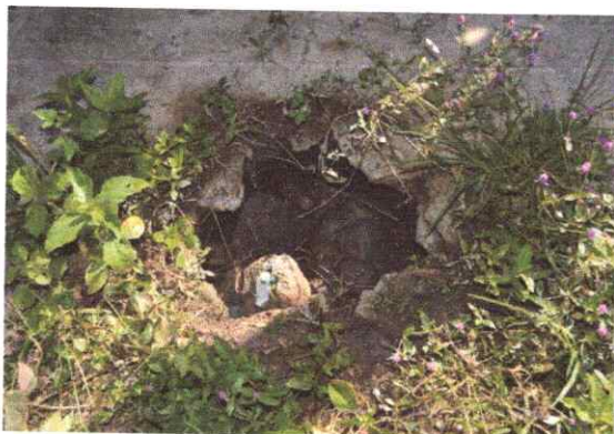
Rede coletora de esgoto sanitário
