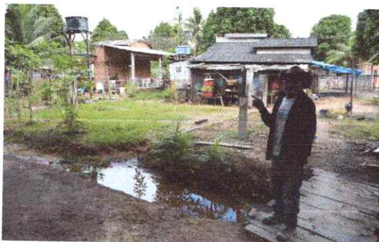
Banheiro sem ligação à rede coletora
