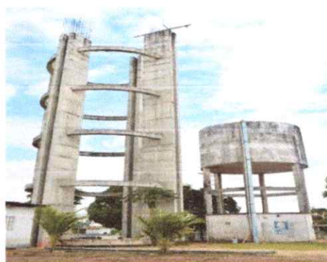
Caixa d'água em construção – sede - convênio Funasa
