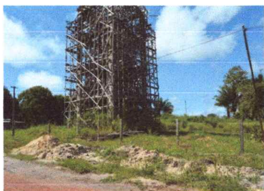
Caixa d'água em construção – Colina convênio Funasa
