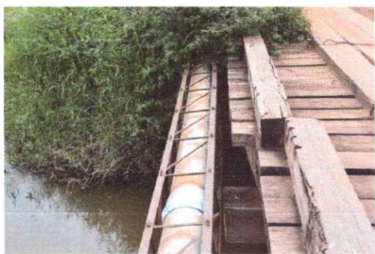
Rede de captação de água - Travessia
